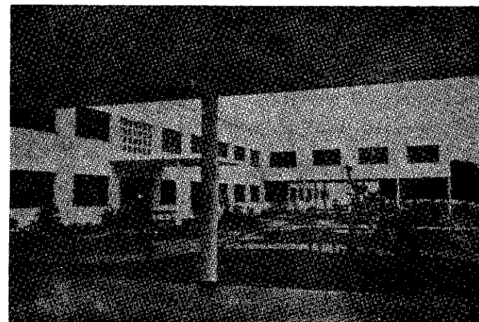
Detalhe da mesma Escola Industrial de Fortaleza. Projeto e construção da Divisão de Obras do Ministério da Educação e Cultura.
